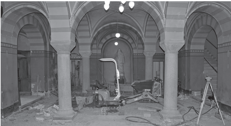
Baumaschinen in der Krypta zum Ausheben der Abtsgräber
