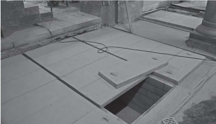
Zwölf Schächte für die neuen Abtsgräber
